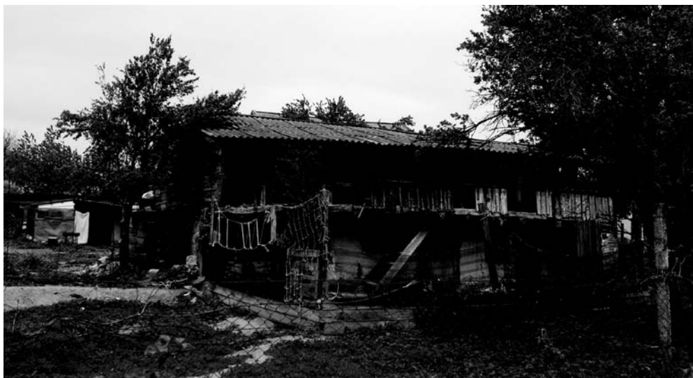
Ил. 6. Плаховый дом с боковой плетневой стеной в с. Плотинное. Фотография автора, 2019 г.
