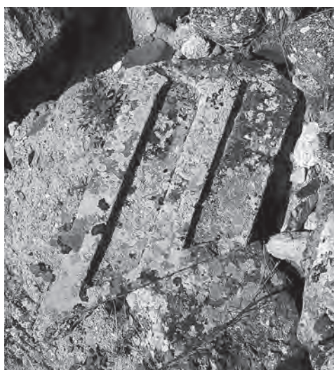
Ил. 10. Ани. Церковь во Внутренней крепости. Плита покрытия шатра. Фото автора, 2019 г.
