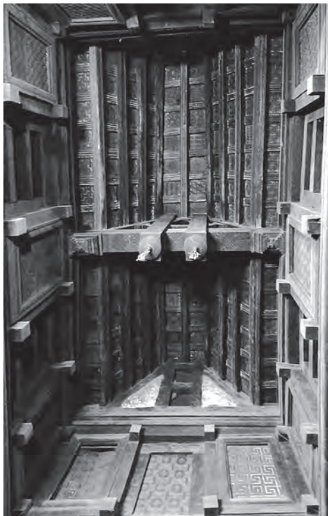
Ил. 5. Оригинальная конструкция «седловидного» перекрытия центрального нефа в церкви Йемреханна Крестос. Фото С. Клюева, 2014 г.
