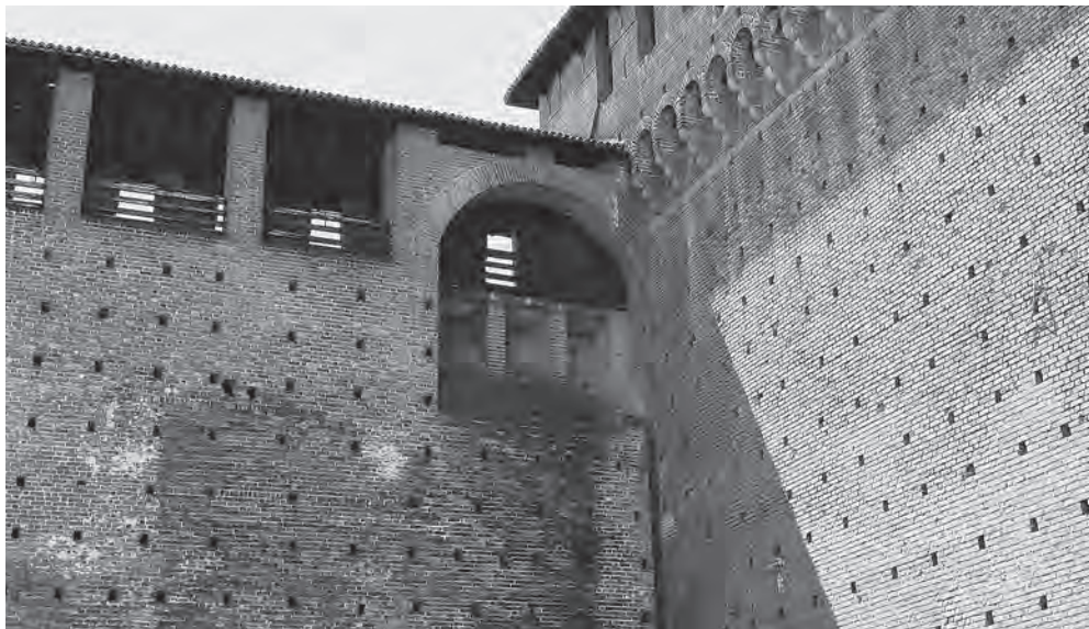
Ил. 5. Проем-ловушка, перекрывавшийся перекидным мостиком. Юго-западная куртина двора Пьяцца д'Арми в месте примыкания к цитадели. Кастелло Сфорцеско. Фото автора, 2017 г.
