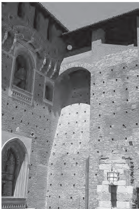
Ил. 6. Проем-ловушка в северо-восточной куртине двора Пьяцца д'Арми в месте примыкания к цитадели. Кастелло Сфорцеско. Фото автора, 2017 г.
