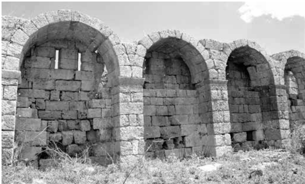
Ил. 6. Куртина восточной стены Перге, вид изнутри. На арках покоился несохранившийся боевой ход. Ниже, между стеной и пилястрами, проходит боевая галерея с двумя бойницами в каждой арке. Фотография К. С. Носова
