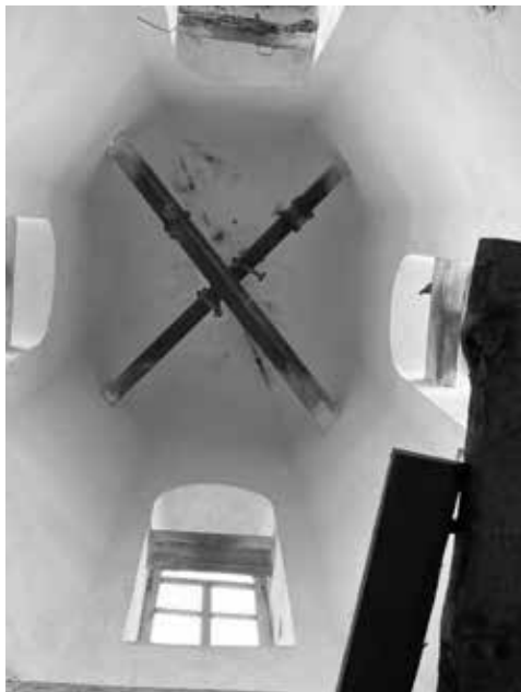
Ил. 9. Колокольня церкви Аменапркич. Внутренний вид. Фото автора, 2021 г.
