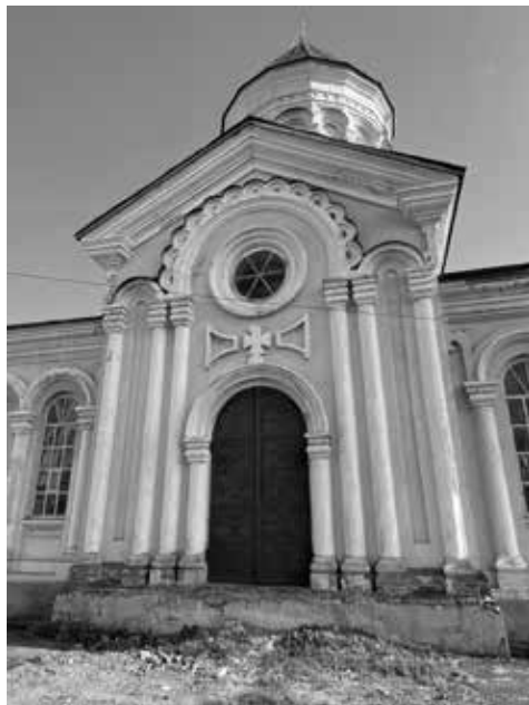
Ил. 10. Центральная часть северного фасада церкви Аменапркич. Фото автора, 2021 г.
