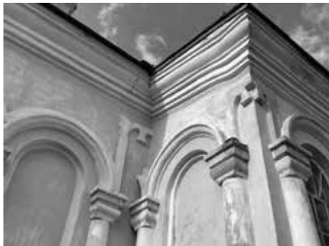
Ил. 12. Церковь Аменапркич. Стык юго-западного угла с южной стеной помещения при колокольне. Фото автора, 2021 г.
