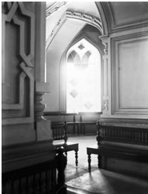
Ил. 13. Машрик ул-Азкар в Ашхабаде. Интерьер. Вид из центрального зала на внутреннюю обводную галерею. Фотография 1920-х гг.
