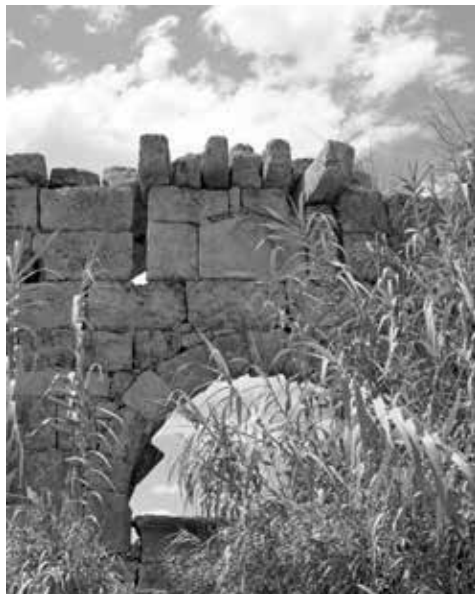
Ил. 9. Второстепенные восточные ворота в стенах нижнего города Перге. Малая Азия, ок. 225 г. до н. э. Над воротным проходом можно видеть четыре консоли, оставшиеся от машикуля-бретеша. Фото автора, 2010 г.
