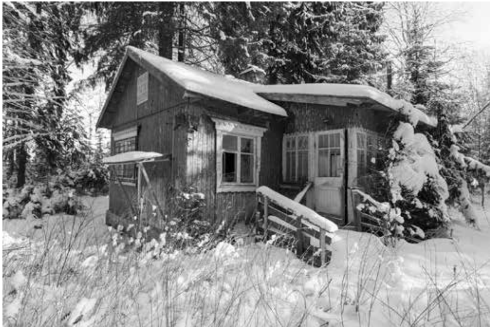
Ил. 8. Заброшенная дача в городе Зеленогорске (Terijoki). Вариант типа 4 для инженеров ВНИПИЭТ, 1947. Фото А. Е. Браво, 2021
