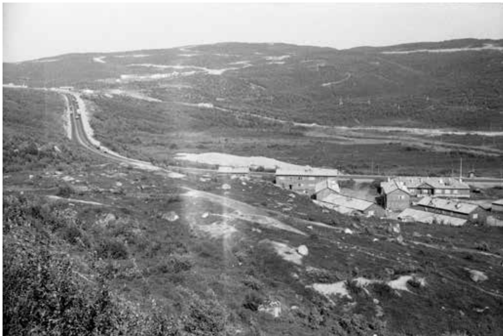
Ил. 1. Группа домов в поселке Нагорное Мурманской области. Преположительно, тип 251 «Двухэтажный жилой дом на восемь квартир», Puutalo, 1946. Фото В. И. Гноевой, 1973 г. (ГАМО Ф.Р-1342)
